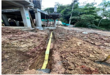
Ilustración 25,Excavación Aguas negras casa 13 Manzana I, Fuente: Autoría propia.
