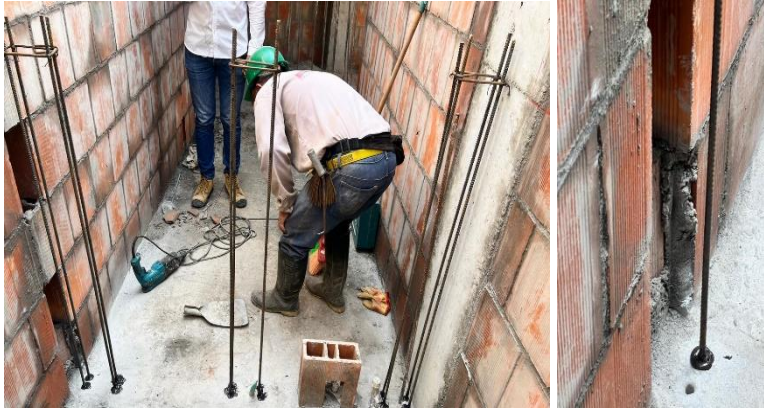
Ilustración 7, Varillas de refuerzo para columnetas ancladas con EPOXYCO, Fuente: Autoría propia.
