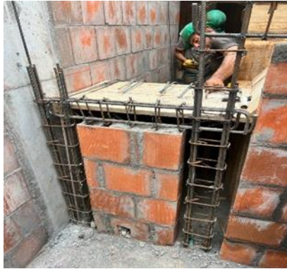
Ilustración 8, Refuerzo de columnetas apoyo escalera, Fuente: Autoría propia.
