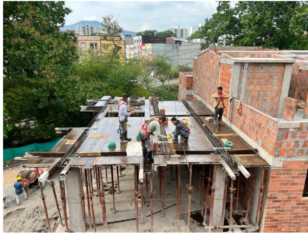
Ilustración 1, Armado de formaleta casa 14B, Fuente: Autoría propia
