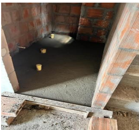
Ilustración 20, Mortero de baño piso 2, Fuente : Autoría propia.
