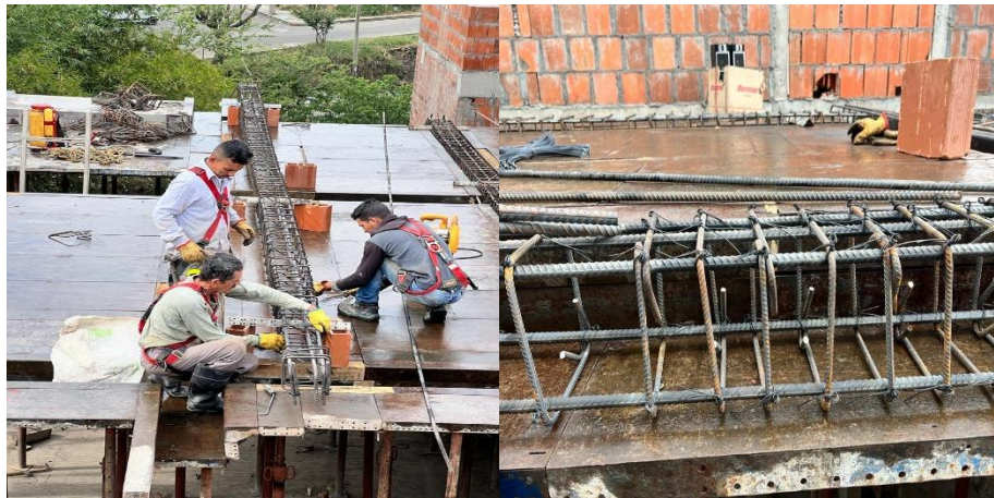
Ilustración 2, Acero de refuerzo para vigas de contra piso casa 14B, Fuente: Autoría propia
