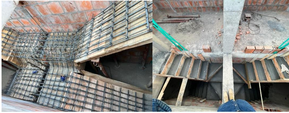
Ilustración 10, Acero de refuerzo y fundida de escalera compartida, Fuente: Autoría propia.
