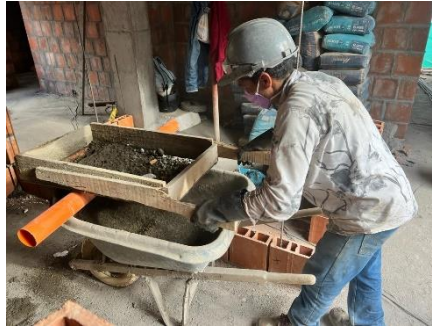
Ilustración 16,Cernido de escombros , Fuente: Autoría propia.
