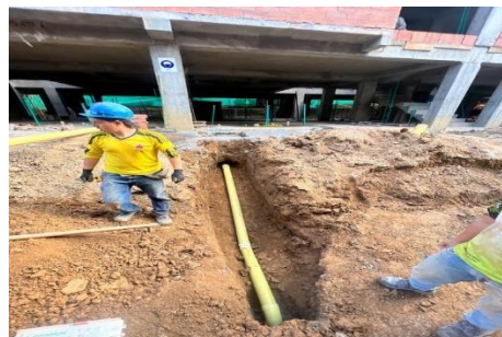
Ilustración 23,Excavación Aguas negras casa 9, Fuente: Autoría propia.
