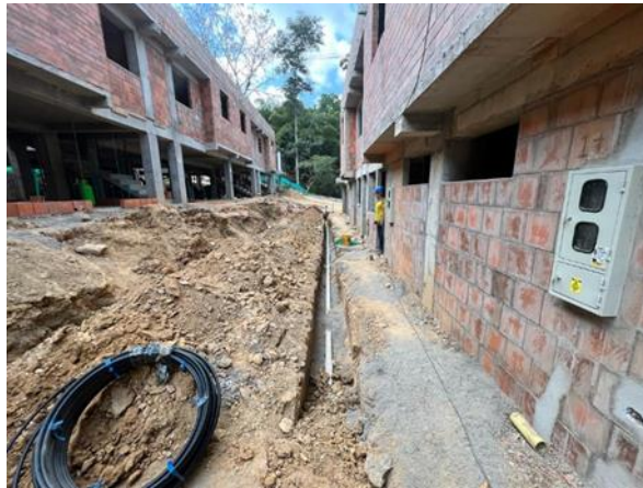
Ilustración 26,Instalación red de acueducto casas 7-11,15-19, Fuente: Autoría propia.
