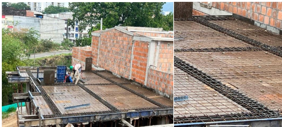
Ilustración 3, Malla de refuerzo para placa de contrapiso casa 14B, Fuente: Autoría propia
