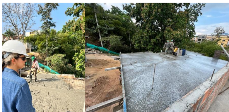
Ilustración 5, Placa de contrapiso con ANTISOL, Fuente: Autoría propia.
