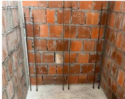
Ilustración 9, Varillas de refuerzo para columnetas ancladas con EPOXYCO, Fuente: Autoría propia.
