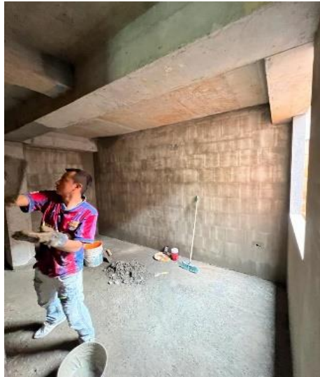
Ilustración 21, Ilustración 20, Aplicación de friso, Fuente: Autoría propia.
