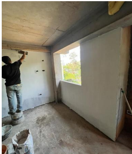
Ilustración 22, Aplicación de estuco , Fuente: Autoría propia.
