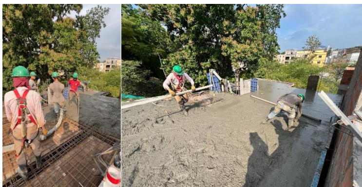
Ilustración 4, Proceso de fundida placa de entrepiso casa 14B, Fuente: Autoría propia
