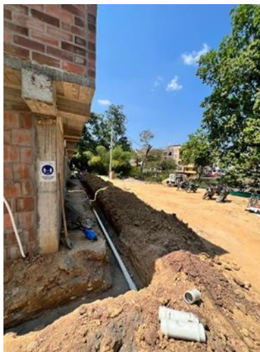
Ilustración 27, Instalación red de acueducto casas 19-23, Fuente: Autoría propia.
