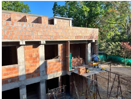
Ilustración 13, Construcción muro en ladrillo Extrublock casa 18B, Fuente: Autoría propia.
